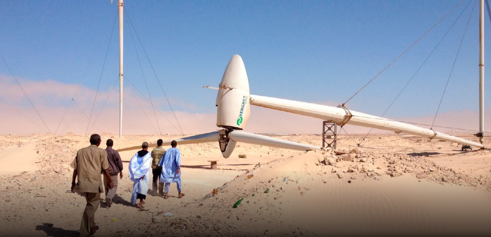
UNDP 毛里塔尼亚团队参观努瓦迪布的一座风力发电厂，检查一台被吹到的涡轮发动机。UNDP 支持毛里塔尼亚政府推动清洁和可再生能源、对提高发电量的计划帮助制定评估方法、扩展电网覆盖及提高可再生能源在国家能源结构中的作用。
