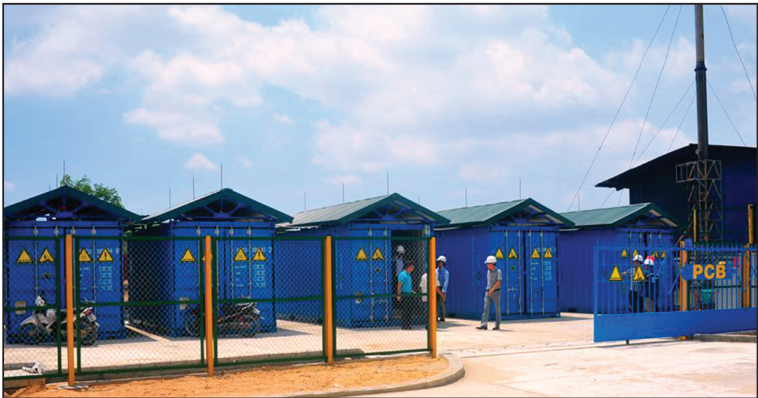
Hình II. 12: Chế tạo kho lưu giữ chất thải PCB dạng contenno
