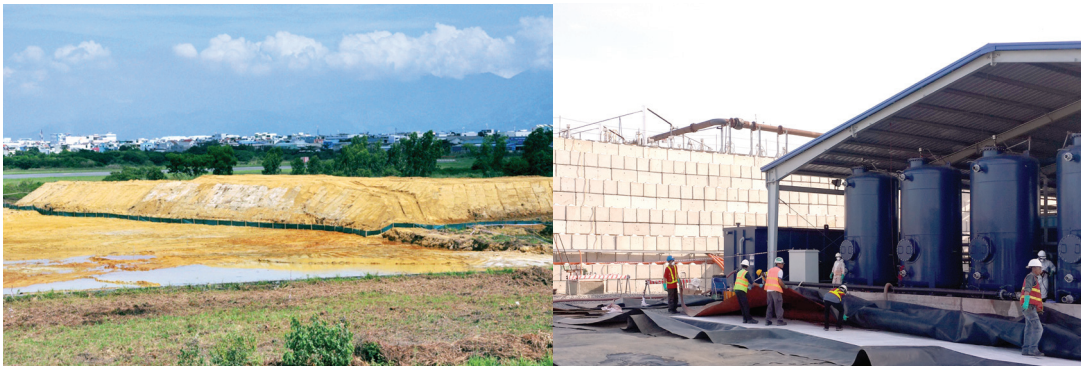
Hình II. 14: Xử lý ô nhiễm Dioxin tại sân bay Đà Nẵng
