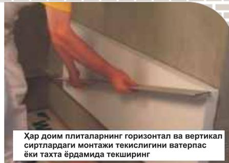
Ҳар доим плиталарнинг горизонтал ва вертикал сиртлардаги монтажи текислигини ватерпас ёки тахта ёрдамида текширинг
