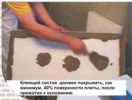
Клеящий состав должен покрывать, как минимум, 40% поверхности плиты, после прижатия к основанию.
