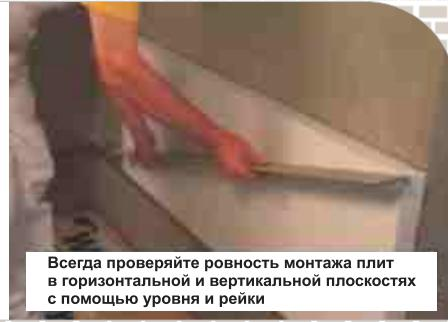
Всегда проверяйте ровность монтажа плит в горизонтальной и вертикальной плоскостях с помощью уровня и рейки
