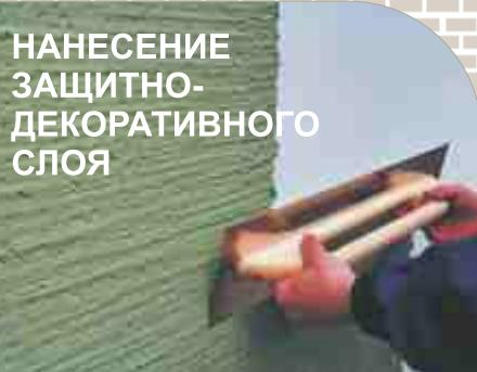
На поверхность фасада наносится защитно-декоративное покрытие. Толщина слоя покрытия должна превышать размер наполнителя, формирующего фактуру покрытия.
