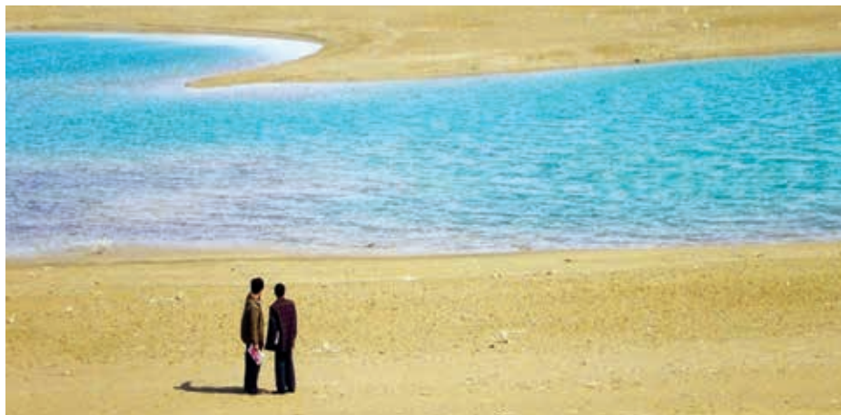
3.1-rasm. O'zan suv omborini loyqa bosishi
