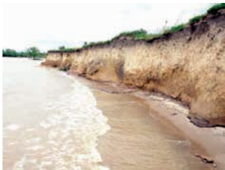
1.2- rasm. Suv ombori qirg'oqlarining yuvilishi holatlari
