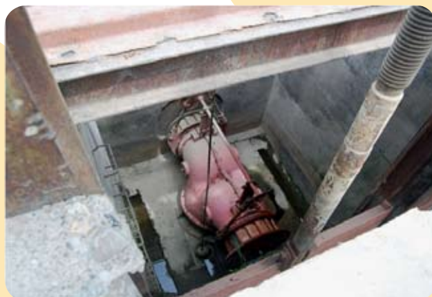
Рустамжон Тошматов Заврақ қишлоғида мустақил равишда ясаган кичик гидростанция турбинаси.
