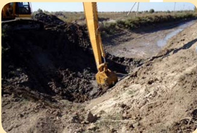
«Наврўз-яп» каналини тозалаш ва тайёрлаш бўйича экскаватор ишлари.
