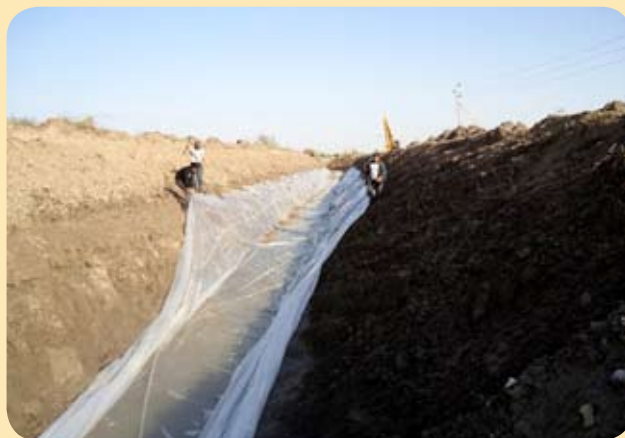
Канал тубига изоляция плёнкасининг ўрнатилиши.
