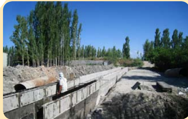
Раҳматулло Шодиев бошчилигида Оқ Мачит қишлоғида кичик гидроэлектростанция учун каналнинг барпо этилиши.
