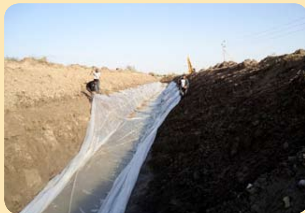
Укладка изолирующей пленки на дно канала.
