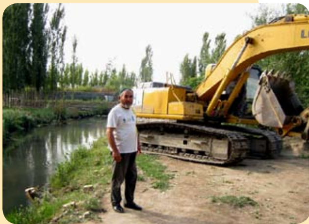
Рахматулло Шодиев перед началом экскаваторных работ.
