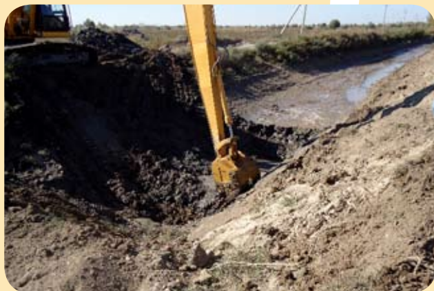
Экскаваторные работы по очистке и подготовке канала «Навруз-яп»
