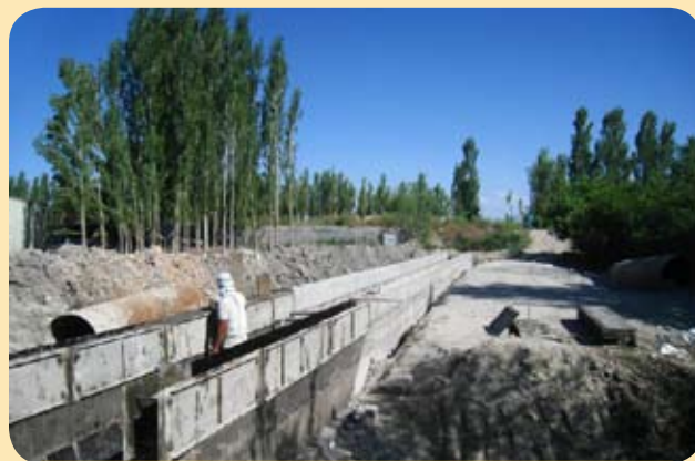
Строительство канала для микроГЭС под руководством Рахматулло Шодиева в поселке Ок Мачит.
