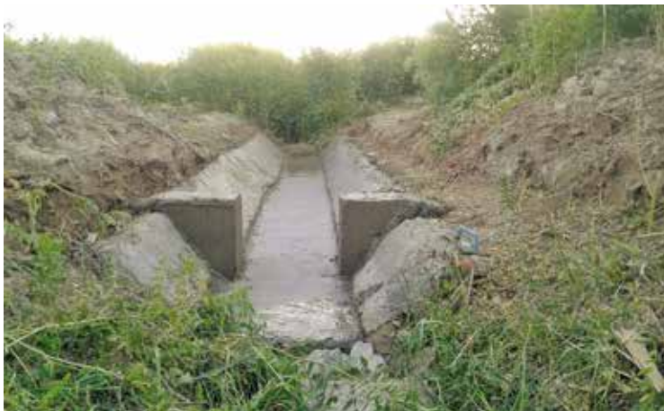
Рис. 11. Устройство водовыпуска и замеры воды по водосливу Чиполетти (Хамзин С.) [2]
