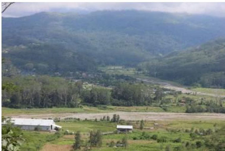
Figura 17 –area inklinado inundasaun iha Gleno, hatudu infra-estruturua iha Risiko. Suco Riheu, Kaptasaun Mota Lois
