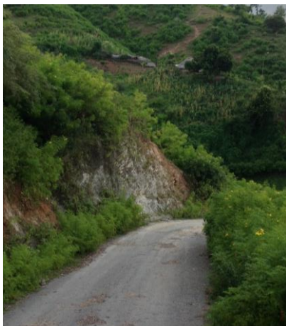
Figura 31. Evidensia risiko as ba rai-halai no erosau hodi tahu Estrada iha risiko. Suco Fatumasi, Kaptasaun Mota Carbutaeloa
