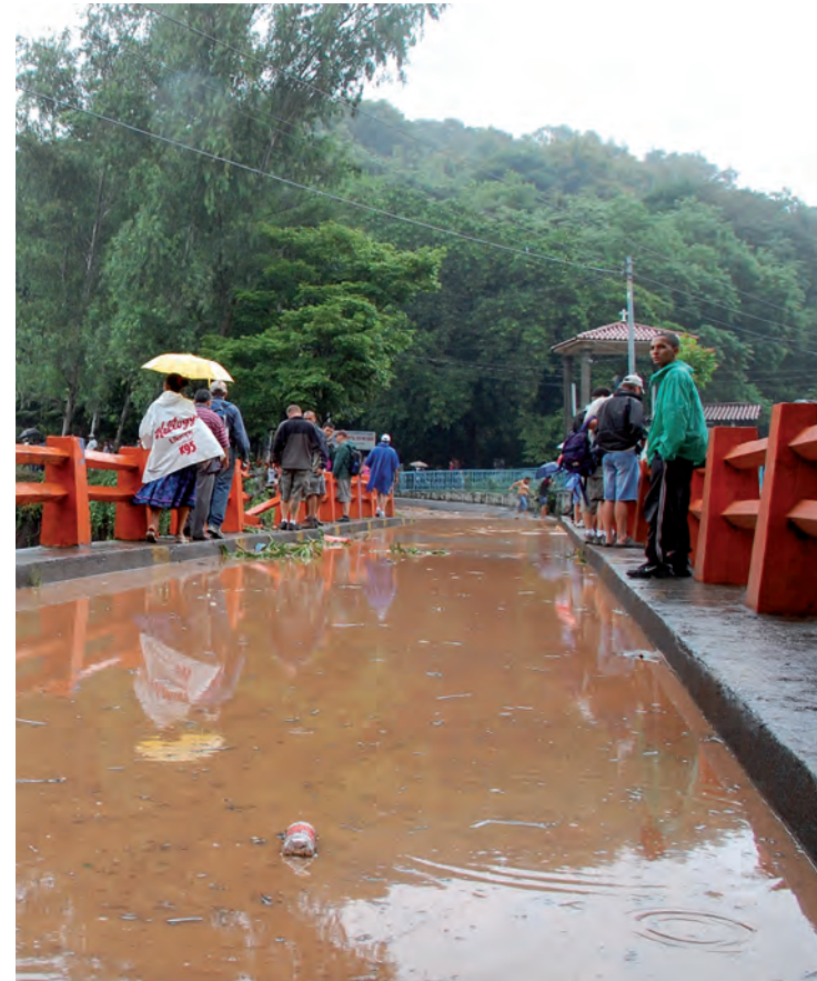
Un pont de San Vicente, au Salvador, inondé par des eaux de ruissellement riches en sédiments. Dans certaines régions du monde, le changement climatique provoque une augmentation rapide et intense des précipitations, ce qui risque de dépasser la capacité du sol à absorber les eaux de pluie. (Référence photographique : PNUD Salvador)
