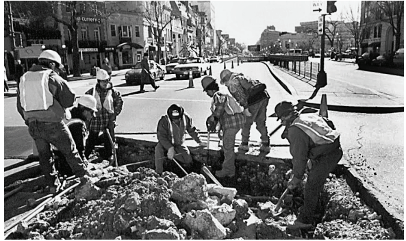
Inmigrantes trabajan en la construcción en USA.
