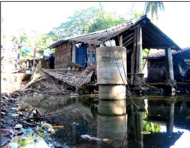
Viviendas inundadas y dañadas en la zona Baja del Río Lempa de Jiquilisco.
