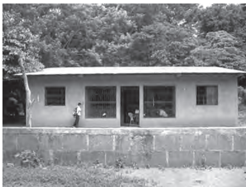
Vivienda de una planta muy transformada en San Jorge, La Conquista
