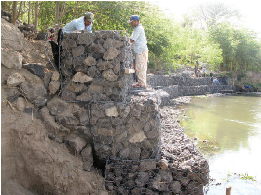
Construcción de bordas de contención.
