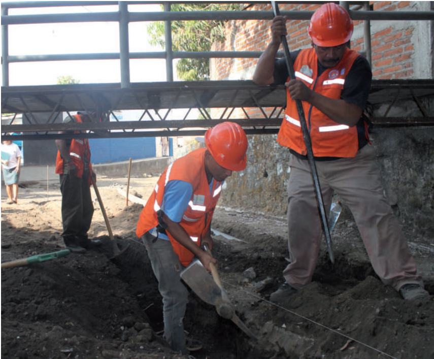
Obras de mitigación por inundación en San Juan Opico.
