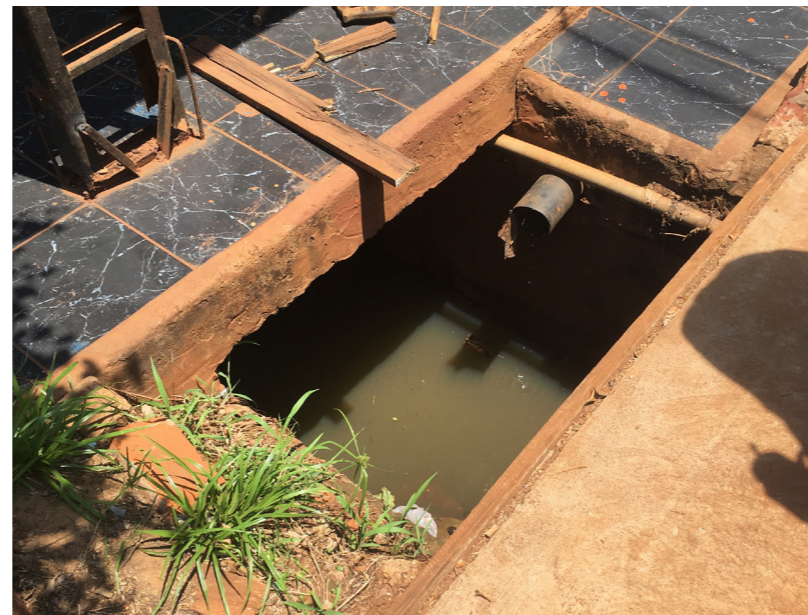
Canales en vías
