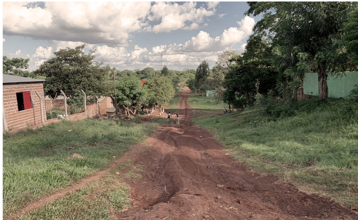
Calle de pendiente alta // Antes
