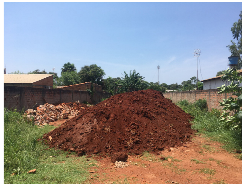
Relleno de terrenos en zona baja
