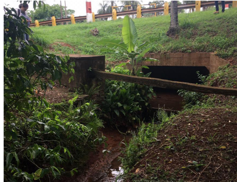
Tubo de paso en Supercarretera
