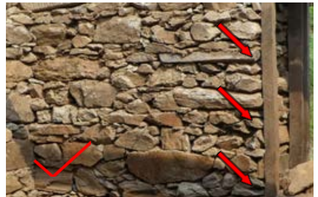
कस लिङ्कलाई सही ठाउँमा राख्नुपर्छ । भ्यालढोकाको आकार सुरुमा अनुमान गरिएको अनुसार भएको अवस्था ।
