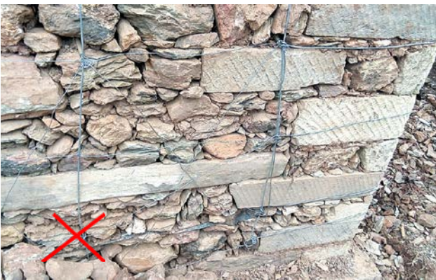
छड्के तारलाई जथाभावी रूपमा जडान गर्नुहुदैन र त्यसलाई घरको गारोको बाहिरी भागमा मात्र राख्नु हुदैन ।
