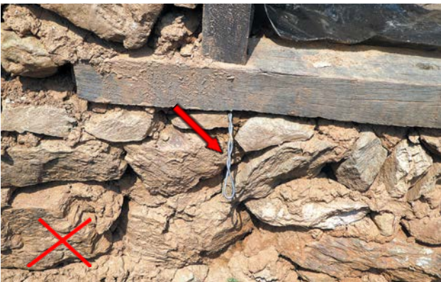
कस लिङ्कलाई गलत ठाउँमा राख्नु हुदैन । भ्यालढोकाको आकार सुरुमा अनुमान गरेको भन्दा फरक भएको अवस्था ।
