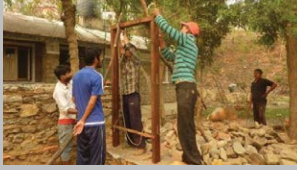
०७ घण्टीमा मिल्ने गरी ढोकाको चौकोस जडान । चौकोसमा होलफास्ट पनि राखिएको ।
