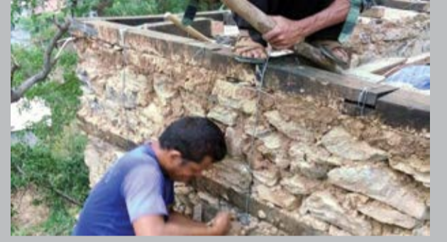
१४ गारोको भित्र र बाहिरपट्टि जस्ता तारलाई बुइंगलमुनि बिछ्याईएको वाल प्लेटसम्म पुऱ्याउने । ठूलूला किला ठोकेर राम्ररी अडकाउने ।
