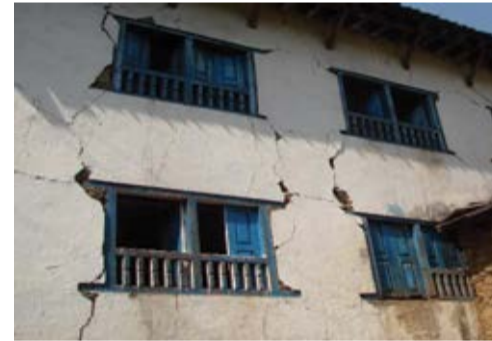
वारपार छिचोले विकर्ण चिराहरू नदेखियुन भन्नाका लागि भ्याल, ढोकाजस्ता खुल्ला भागमा चौकुने बन्धनहरू राख्नुपर्छ ।
