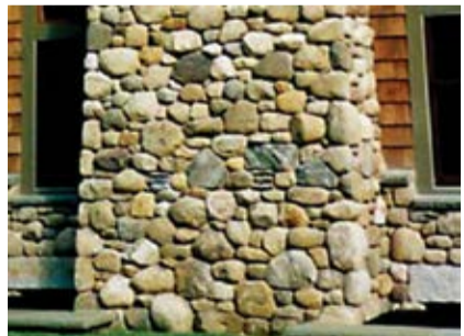
०१ गोलाकार या डल्ला ढुङ्गाहरू कहिल्यै प्रयोग नगरौं । यस्ता ढुङ्गा प्रयोग गरी बनाईएको गारो सानो धक्काले पनि क्षतिग्रस्त हुनसक्छ । यस्ता ढुङ्गालाई फुटाएर चेटा, सर्लकक परेका ढुङ्गा बनाउनुपर्छ ।
