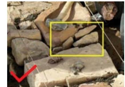
०९ गारोको घर या गुभोमा माटो भर्नु हुँदैन । टिककका ससाना ढुङ्गामा माटोको मसला मिलाएर खदिलो गरी भर्नुपर्छ ।
