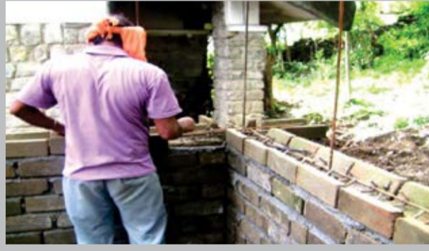
०८ भ्यालको तल (सिल लेभल) अंग्रेजी अक्षर 'यु' आकारका ब्लक र रड राखी फ्लिन्थ ब्याण्ड बनाउने ।
