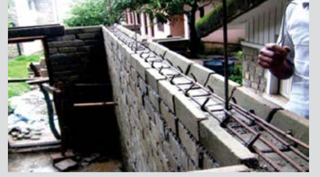
०३ रड र अंग्रेजी अक्षर 'यु' आकारका ब्लक राखेर तयार पारिएको सिल ब्याण्ड
