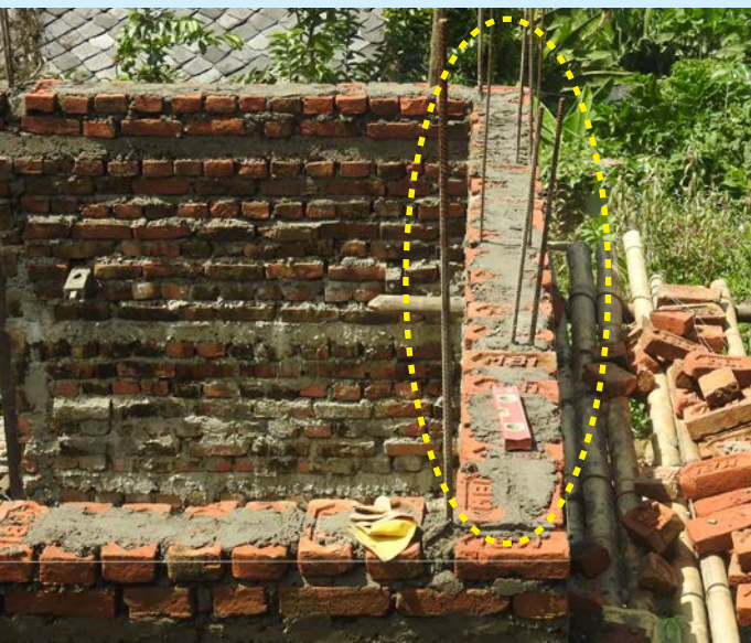
काम सकिएपछि इट्टामा भएको खाँच परेको भागलाई बाँकी भएको मसलाले भरिदिएको
