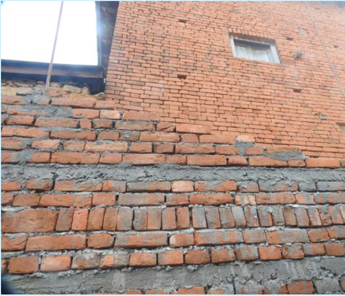
अथाभावी तरीकाले निर्माण गरिएको इट्टाको गारो; इट्टाहरु समानतापूर्वक नराखिएको
