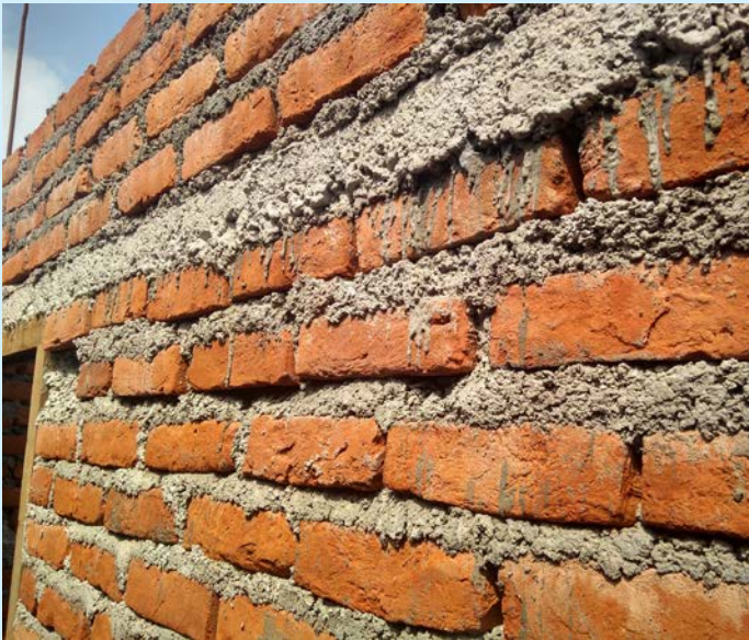
अनियमित मोटाइ भएको मसलाको जोर्नीहरु; इट्टाहरुको गलत व्यवस्थापन; घण्टी नमिलाइकन लगाएको गारो
