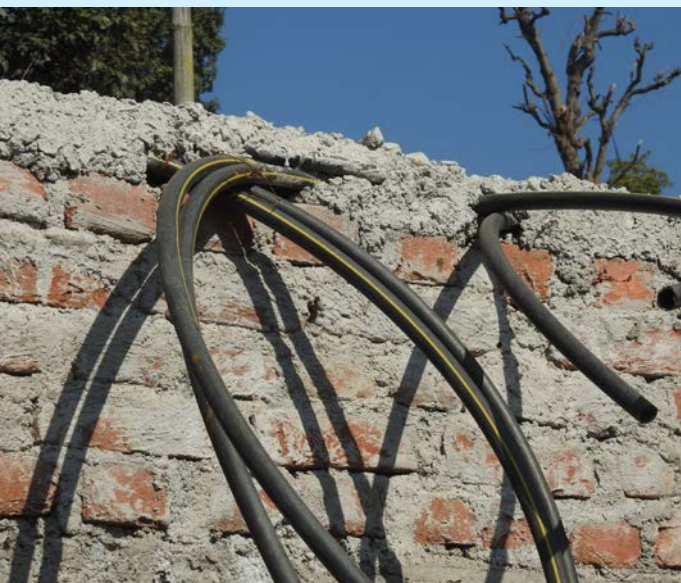
ढलान पट्टीबाट पाइप निकालिएको
