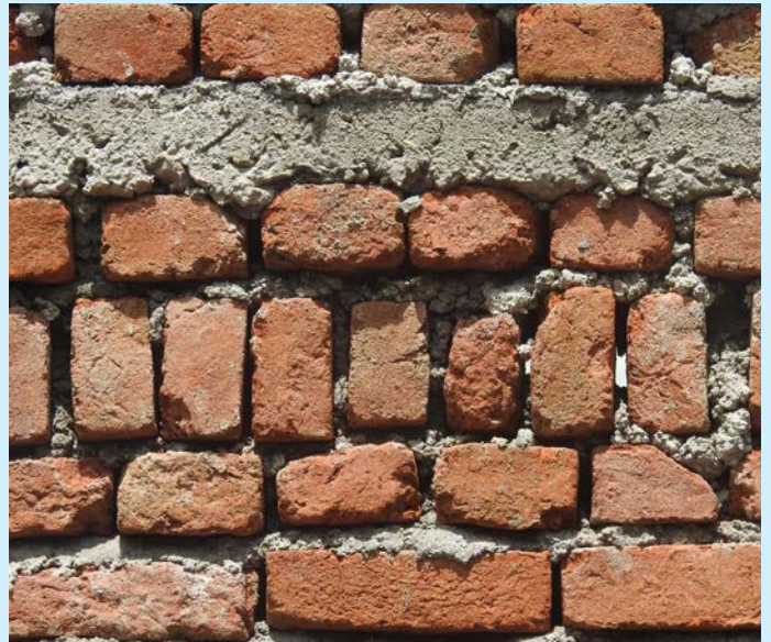
अनियमित मोटाइ भएको मसलाको जोर्नीहरु; इट्टाहरुको गलत व्यवस्थापन; घण्टी नमिलाइकन लगाएको गारो
