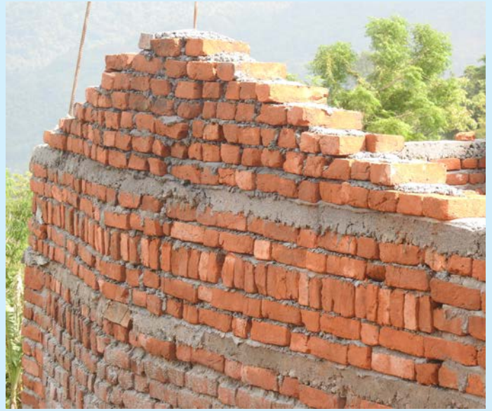
अथाभावी तरीकाले निर्माण गरिएको इट्टाको गारो; इट्टाहरु समानतापूर्वक नराखिएको
