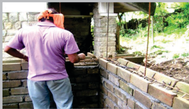
०८ भ्यालको तल (सिल लेभल) अंग्रेजी अक्षर 'यु' आकारका ब्लक र रड राखी फ्लिन्थ ब्याण्ड बनाउने ।
