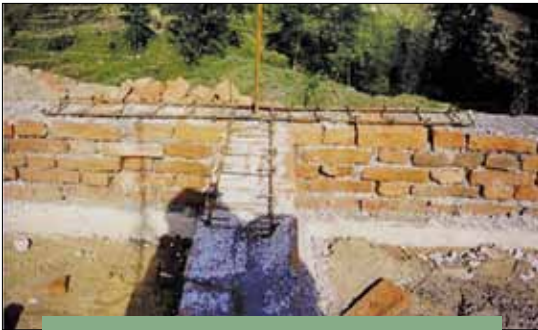
टी जोर्नीमा बन्धनको निर्माण
