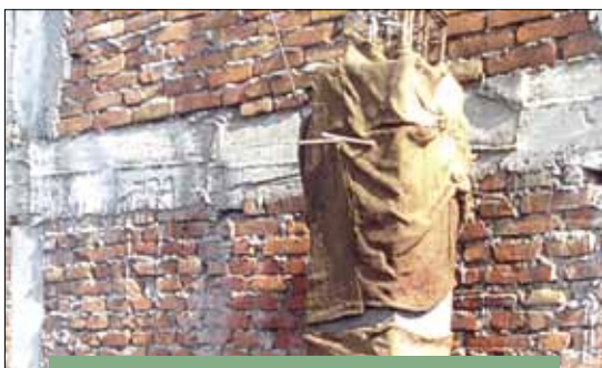
पिलरमा पानीले भिजाउन (Curing) जुटको बोरा प्रयोग
