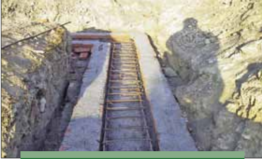
जग बन्धनको निर्माण
