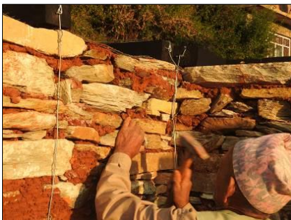
(d) Participant installing vertical wires
