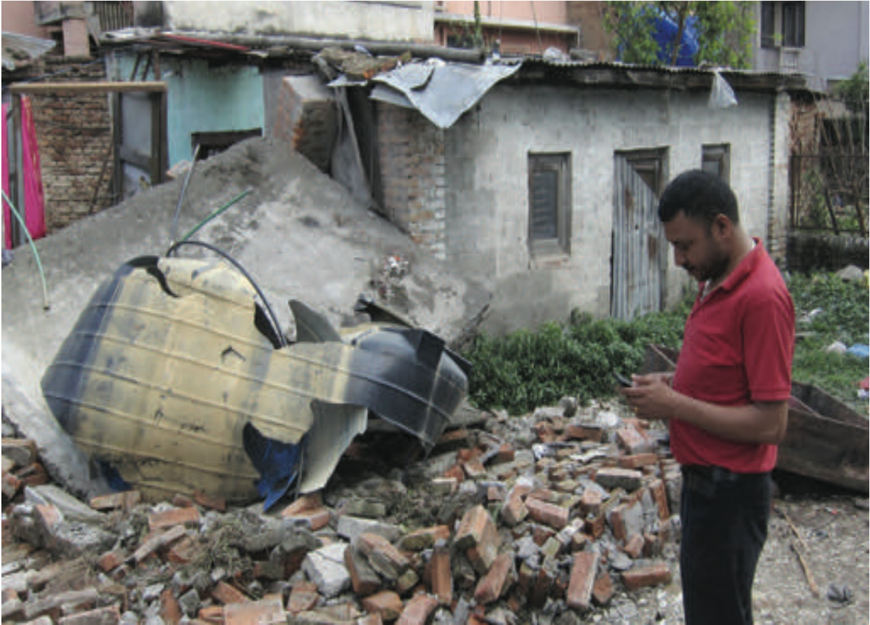
चित्र ३.६५ : भूकम्पबाट क्षतिग्रस्त खानेपानीको ट्याङ्की र पाइप
