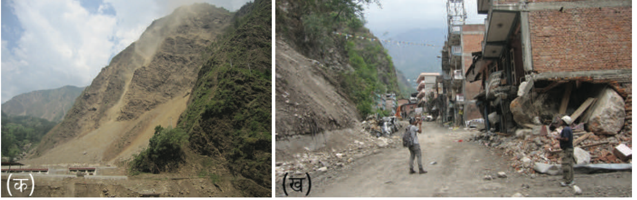
चित्र ३.६ : गोरखा भूकम्पले काठमाडौं-कोदारी सडक खण्डमा उत्पन्न गरेका पहिरोहरू (सैजन्यः दीपक चम्लागाई) । (क) तातोपानी सुख्खा बन्दरगाह पछाडिको पहिरो (ख) कोदारी बजारका पहिरोले क्षतिग्रस्त घर तथा सडक
