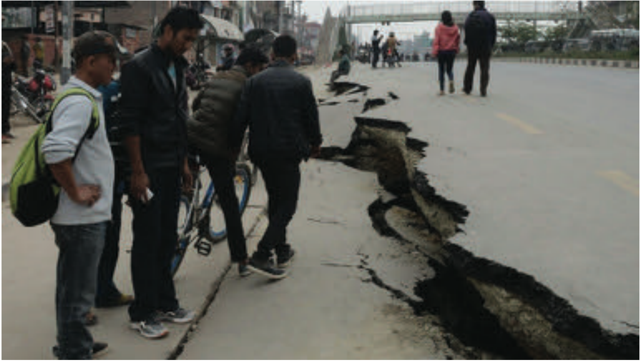
चित्र ३.६३ : कोटेश्वर-सूर्यविनायक सडक खण्ड अन्तर्गत कौशलटार खण्डमा भूकम्पबाट उत्पन्न भएका चिराहरूबाट क्षतिग्रस्त सडक (सौजन्य: दीपक चम्लागाई)
