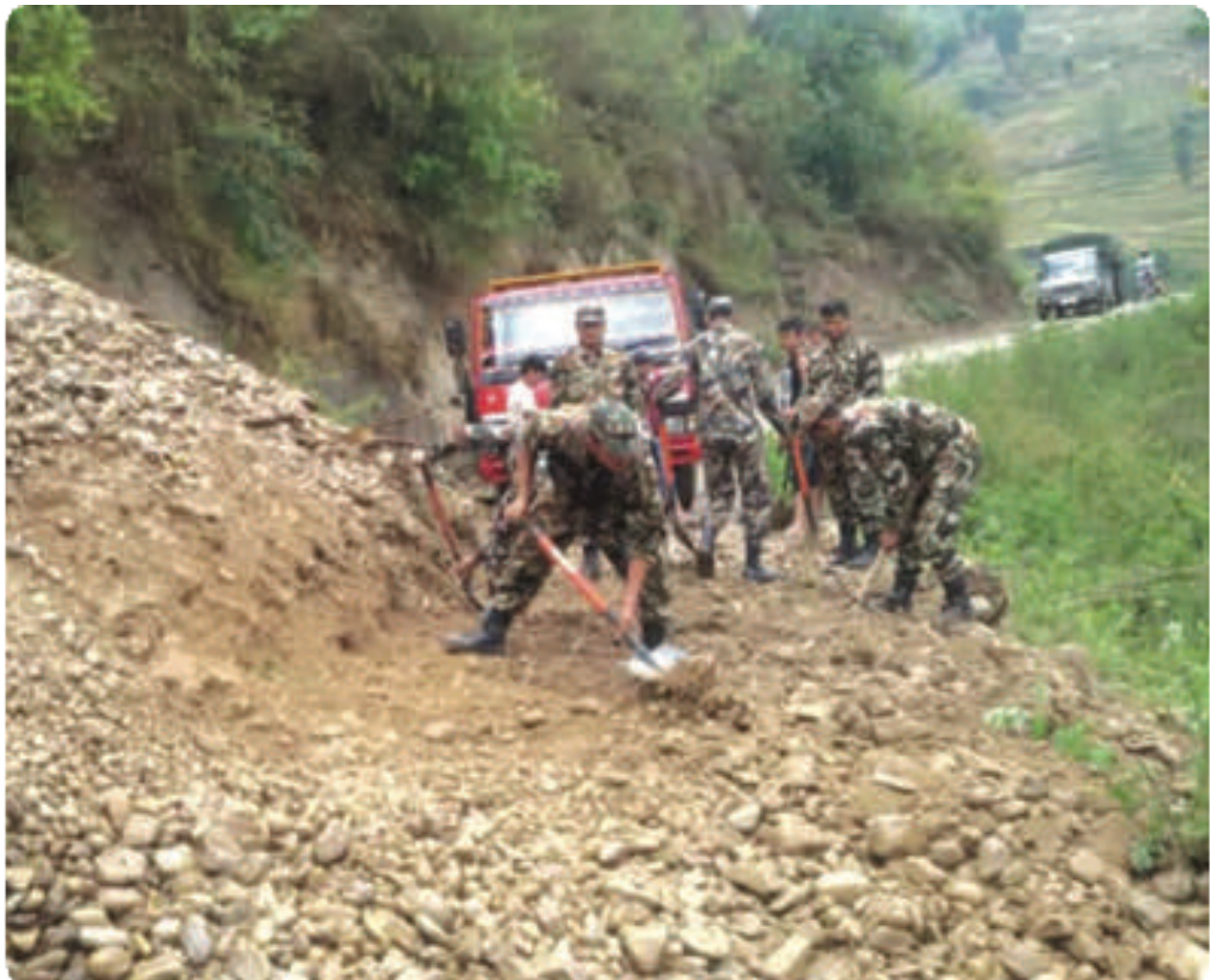
चित्र ४.६ : अबरुद्ध बाटो खुलाउने कार्यमा व्यस्त नेपाली सेना (सौजन्य : नेपाली सेना)
