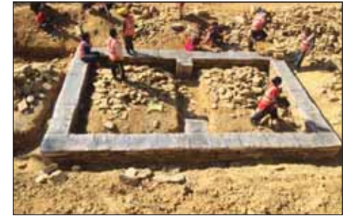
कुसीँ बन्धन: अन्य स्थानमा पनि कुसीँ बन्धन जस्तै अरु बन्धनहरू राख्ने
