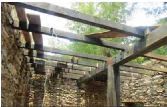
काठको वाल प्लेट माथि जस्ता तारहरूको बिचमा राखिएको काठको तक्तीहरू
