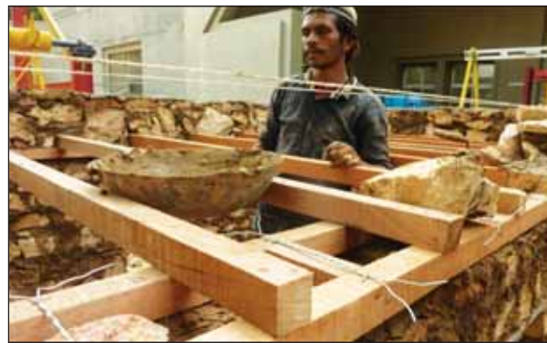
काठको वाल प्लेट माथि जस्ता तारहरूको बिचमा राखिएको काठको तक्तीहरू
