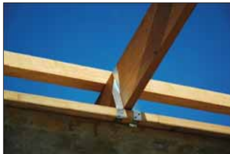
वाल प्लेट र भाटाहरू बीच जोर्नीहरूमा झिल प्रयोग गरी पाइलट प्वाल बनाई फलामको पाताले जोड्नु पर्दछ
