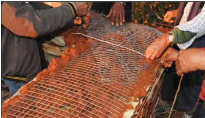
क्रस लिंकलाई घण्टिको प्रयोग गरि उपयुक्त स्थानमा राख्ने
