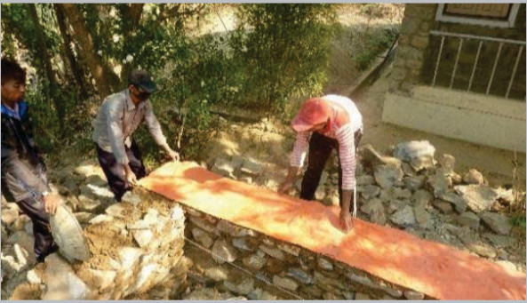
०४ जमिन सतहमा ओस निरोधक पट्टी राख्ने । त्रिपाल, बोरा, प्लाष्टिक प्रयोग गर्न सकिन्छ ।
