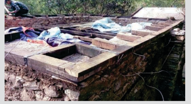
१३ काठको तलो छापेपछि बुइंगलको लागी गारो लगाईयो । वाल प्लेट जडान गरियो । र, बेल्लेड वायर मेस पनि राखियो ।
