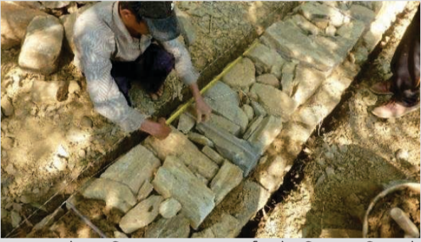
०३ गारो जमिन सतहमा आईसकेपछि प्लाष्टिकले छोपिएको जस्ता तारको 'क्रस लिंक' राख्ने । यो ढोका र भूयाल पर्ने ठाउँको दुबैतिर राख्ने । गारोको भित्रपट्टी ३ इञ्च छोडेर राख्ने ।
