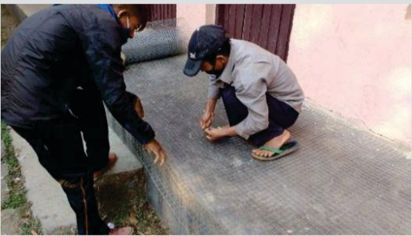
०५ कुर्सी तह बन्धन (प्लिन्थ लेवल ब्याण्ड) का लागी १४ गेजको वेल्ड वायर मेस ।
