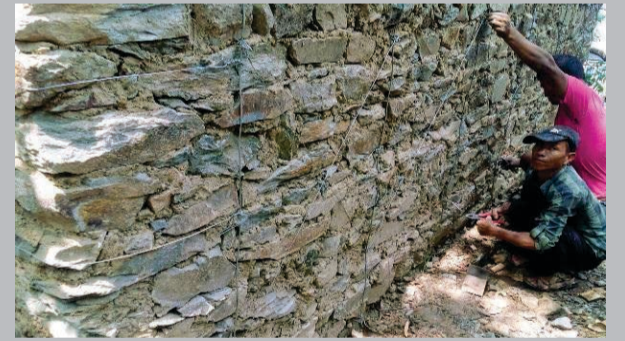
१६ २ मिलिमिटर व्यासको तार सस्याना कोठा हुनेगरी वारपार पारेर बाध्ने । यो काम बुइंगलको भागमा तथा प्लिन्थ र सिलको बिचमा गर्नुपर्छ ।
