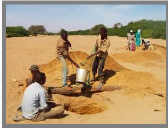
Creusement des puits de recharge des nappes phréatiques, Iférouane © UNDP Niger
