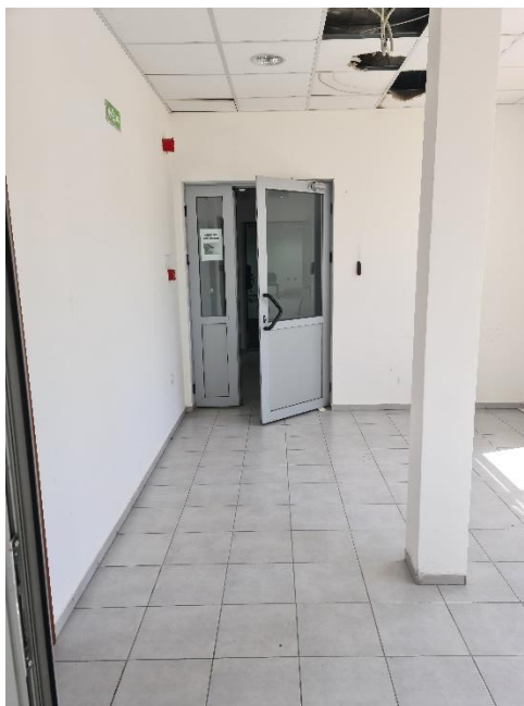
Slika 13. Ulaz u DRS DataCentar
