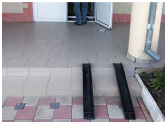
2020 – Импровизированный пандус из металлических рельсов
