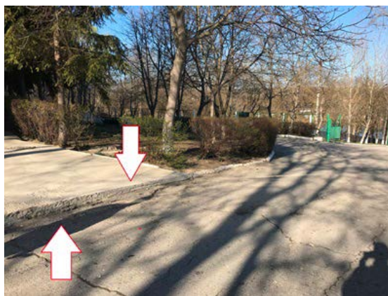
Бетонированная поверхность, бордюр около 15 см
