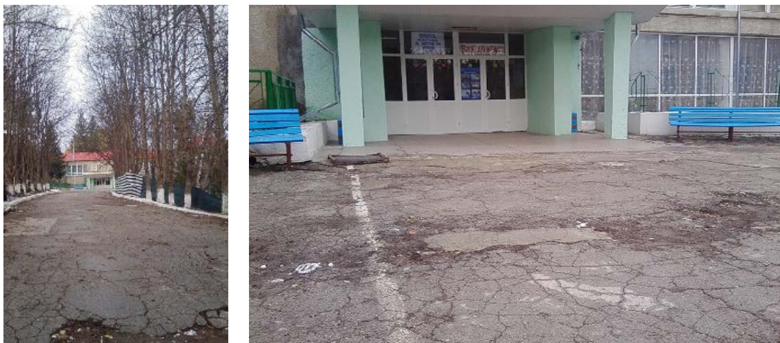
Неровное покрытие тротуара и дороги, отсутствие тактильно-контрастных указателей
