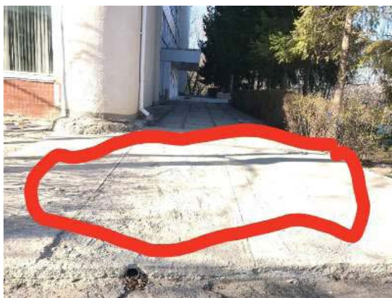
Бетонированная поверхность, бордюр около 15 см
