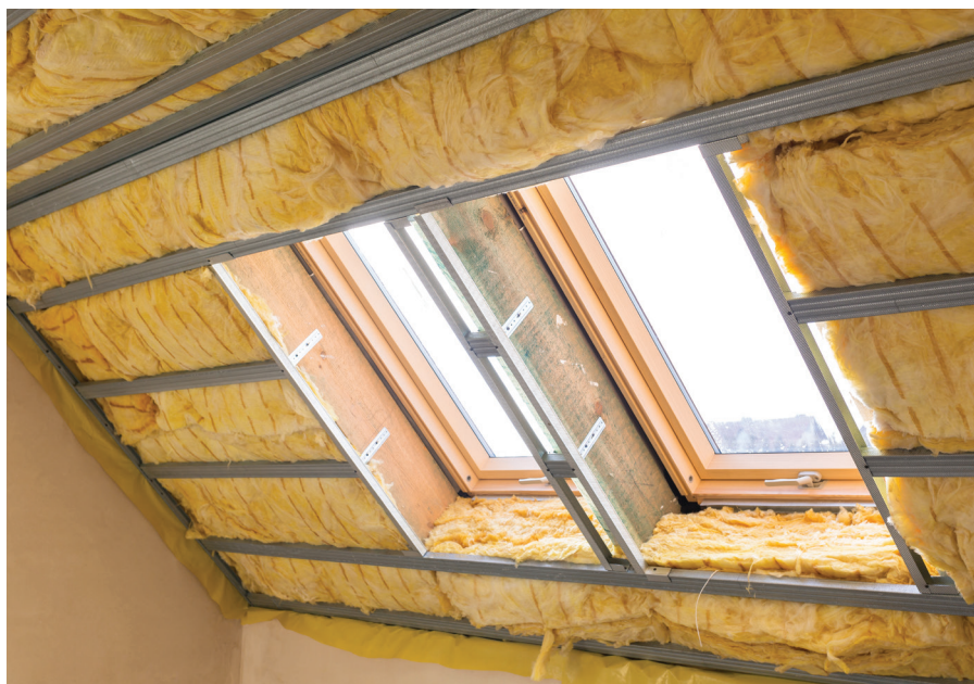
Figura 9. Izolarea acoperișului 10
