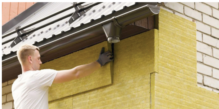
Figura 8. Izolarea pereților 9
