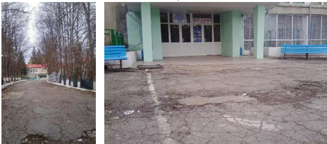
Porțiuni de trotuar și drum avariate, suprafață asfaltată, lipsa pavajului tactil sau marcajului contrastant
