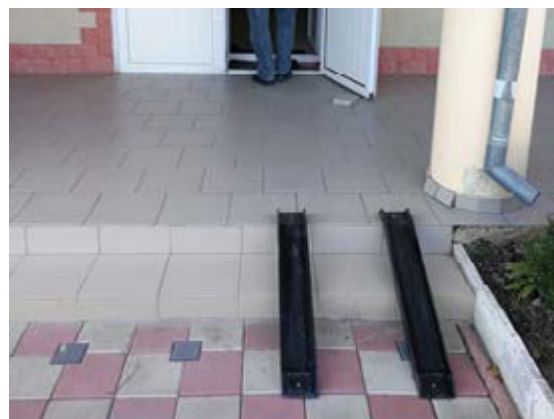
2020 - Rampă improvizată din șine metalice
