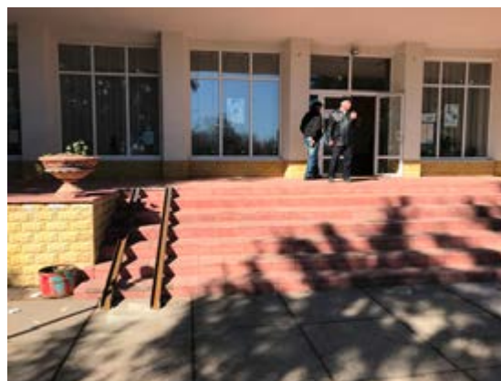
2020 – Rampă improvizată din șine metalice
