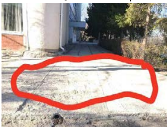
Suprafață betonată, bordură de circa 15 cm
