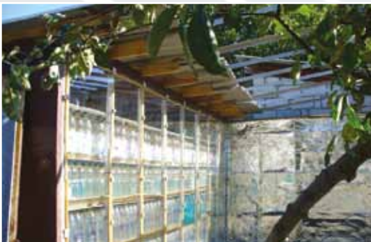
Фото 5. Аккумулятор тепла из 3000 пластиковых бутылок, сооруженный рядом с теплицей
