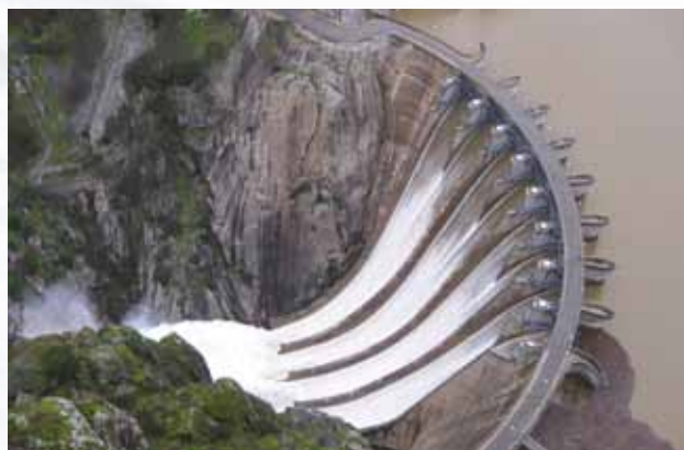
Фото 26. Гидротехническое сооружение, предупреждающее разрушение дамб
