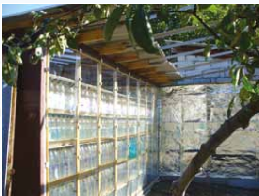
Fig. 12. Acumulator de căldură din 3000 de sticle din plastic, construit lângă o seră (1)
