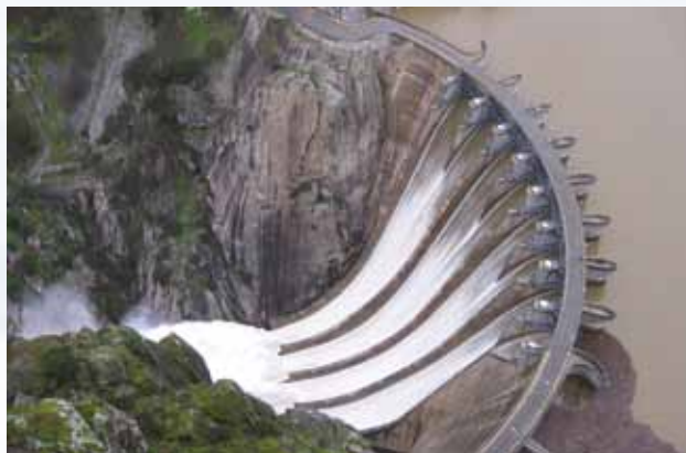
Fig. 39. Construcție hidrotehnică ce previne deteriorarea dambelor
