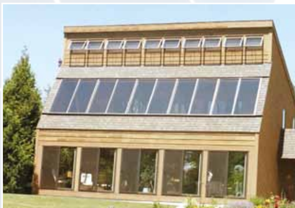
Fig. 8. Clădire solară pasivă
