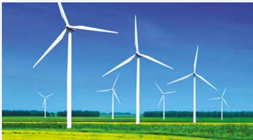
Fig. 26. Parc de turbine eoliene
