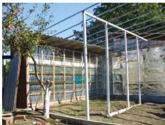
Fig. 13. Acumulator de căldură din 3000 de sticle din plastic, construit lângă o seră (2)
