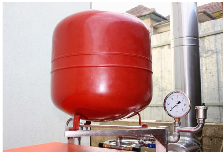
Fig. 4. Vas de expansiune
