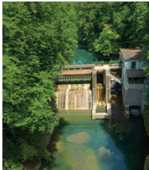
Fig. 3.1.9. Minihidrocentrală pe râul Kokra, Slovenia.
