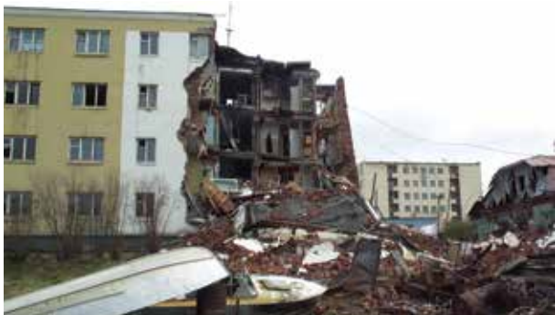
Fig. 2.8.10. Clădirea s-a prăbușit în satul Cerski (Rusia).
