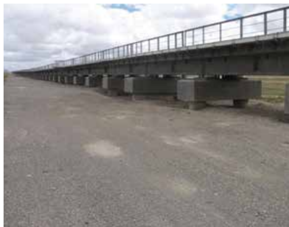
Fig. 2.8.14. Drum amenajat pe suporturi speciale îngropate în pământ.
