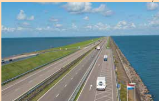
Afsluitdijk este cel mai mare baraj din Europa.
