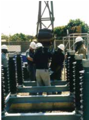
Foto 34. Retirada de servicio de banco de capacitores.
