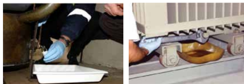
Foto 10. Proceso de toma de muestra de aceite.
