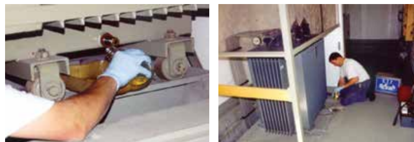
Foto 9. Ilustración de válvulas que se utilizan para tomar muestras en transformadores grandes.
