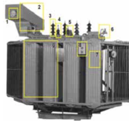
Partes que componen el transformador con aceite y con un depósito de expansión
