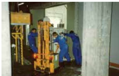
Foto 33. Remoción de un transformador con PCB.
