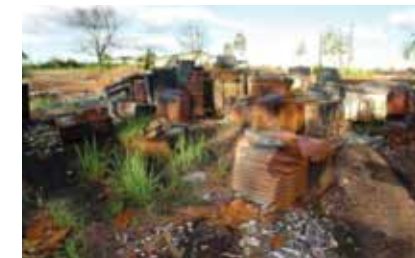
Foto 31. Restos de transformadores en un patio.
