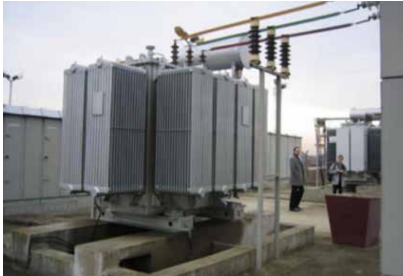
Foto 1. Sistema cerrado-transformador.
