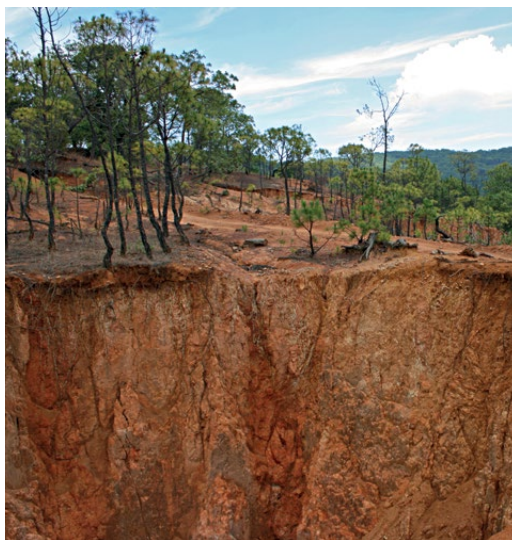
ERO – Áreas erosionadas o sin vegetación aparente.
