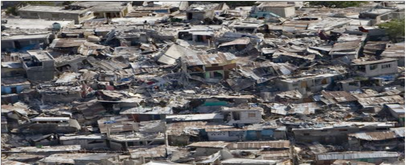
Una vista aérea muestra la extensión del daño causado por el potente terremoto que sacudió la capital de Haití en enero de 2010 (© UN Photo/ Logan Abassi).
