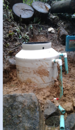
Zanjeo de tubería e instalación de tanque PEAD Boca Tapada (San Carlos)
