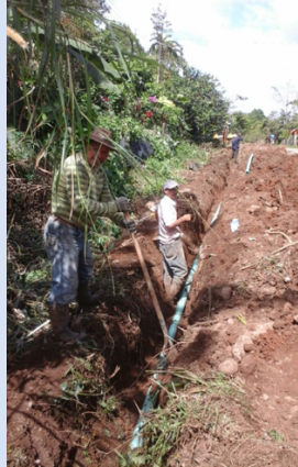
Instalación de tubería en ASADA Colonia Huetares (Sarapiquí)
