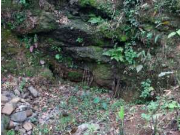
Vista del LCI Choa Pila.
