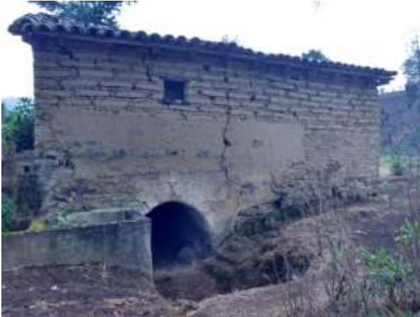
Vista del cárcavo que devuelve el agua del Antiguo Molino 1.
