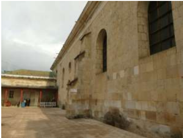
Vista del lado norte de la Iglesia.
