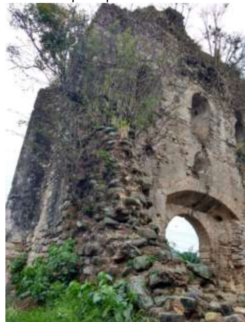
Detalle de los muros y vista interna
