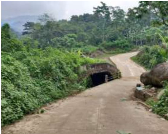
Vista panorámica hacia el norte del puente.
