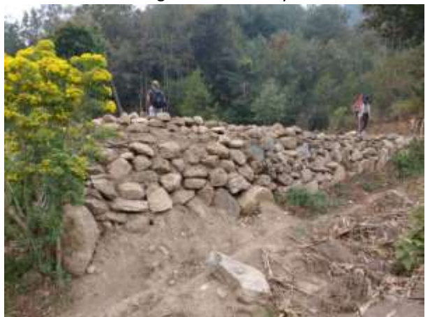
Muro de contención del Juego de Pelota.
