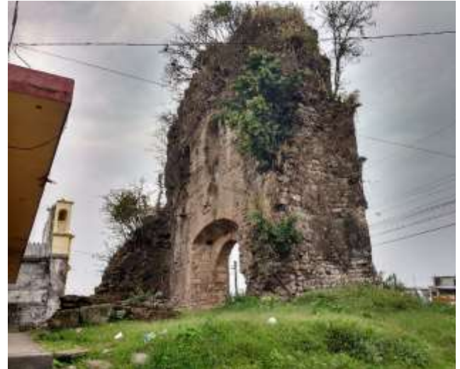
Vista norte parte posterior de la Fachada
