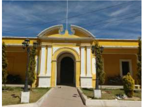
Vista de fachada. Detalle en remate por el que recibe su nombre.
