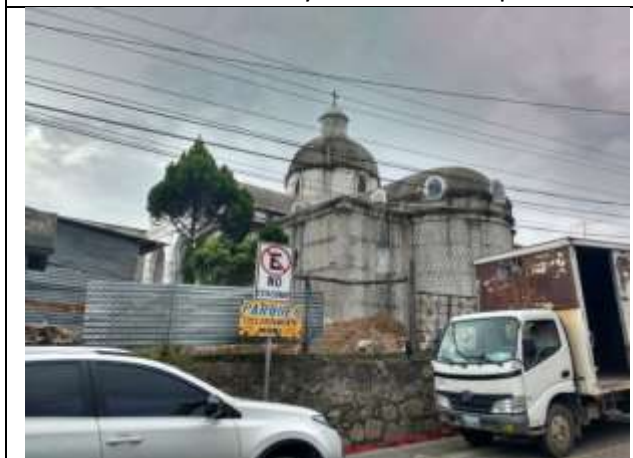
Vista posterior de la edificación.
