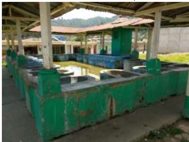
Vista de las pilas y poza del lavadero municipal.
