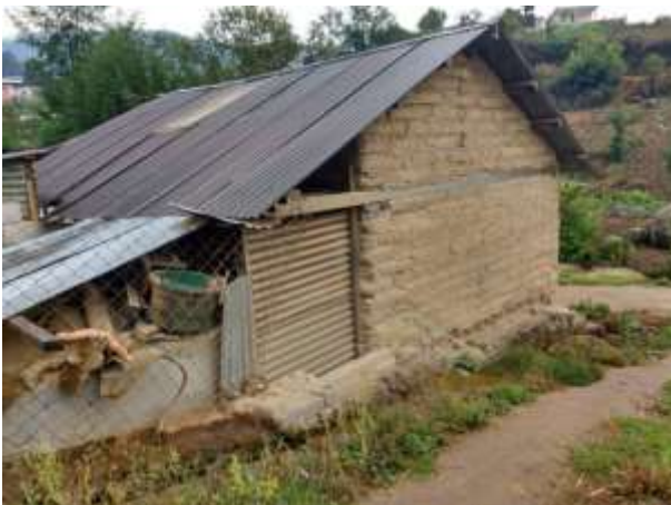
Vista lateral del Antiguo Molino 1, donde se encontraba habilitado el cuarto de molido.
