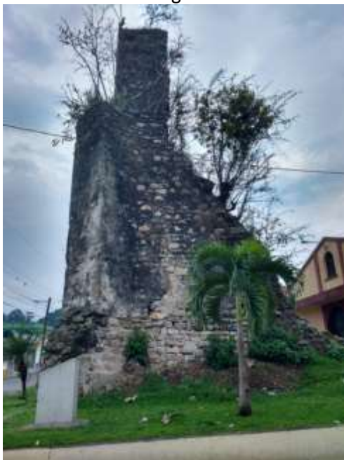
Vista lateral sur de la Iglesia
