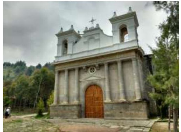
Fachada de la iglesia y lado este
