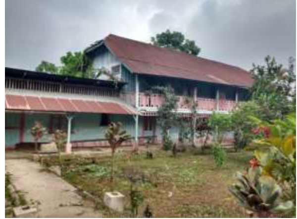
Estructura de la antigua casa patronal
