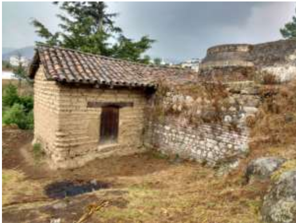
Compuerta de entrada al cuarto de molido.
