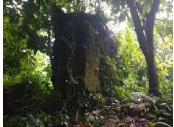
Detalle de contrafuerte muro lado sur
