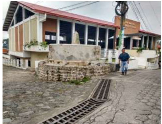
Vista desde la calle principal esquina opuesta
