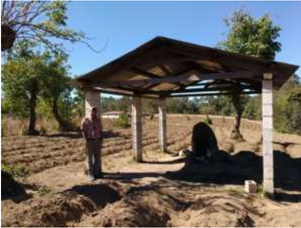
Estructura que protege el monumento lítico.
