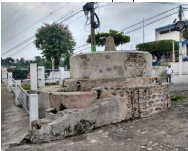
Vista desde la calle que sube a la iglesia
