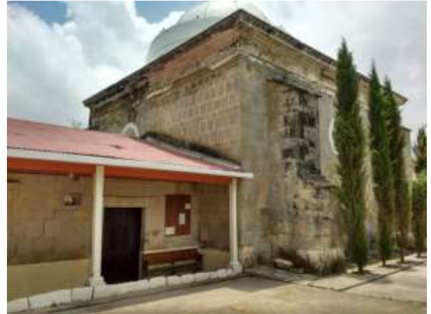
Detalle de parte ingreso posterior
