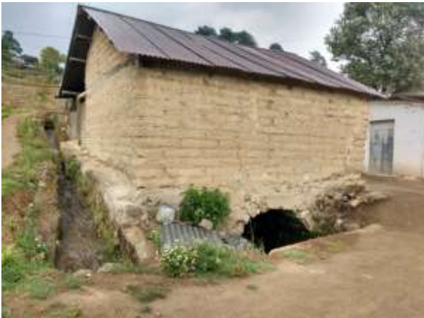
Vista del canal que recibe el agua y el cárcavo, espacio por donde se devuelve el agua al río.
