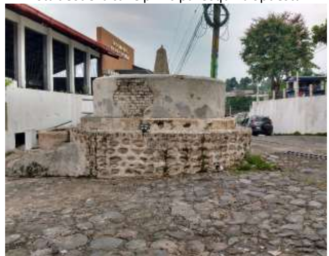
Vista desde la calle que sube a la iglesia
