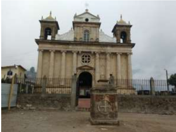
Vista de la fachada de la Iglesia.
