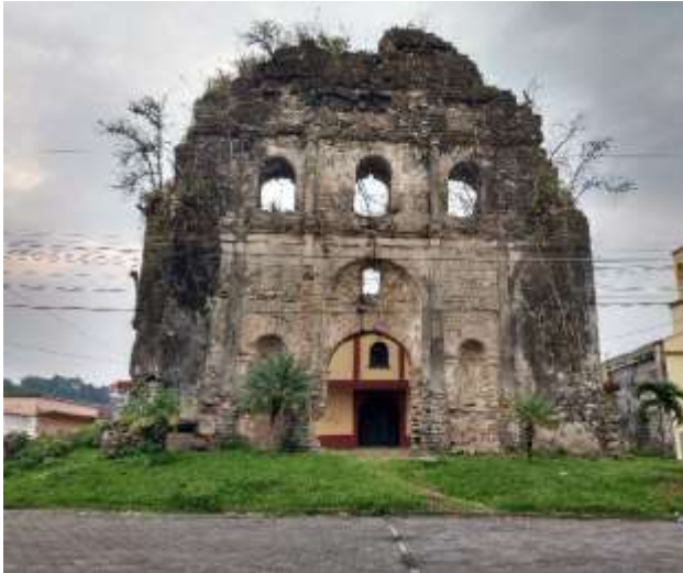
Fachada de la iglesia colonial
