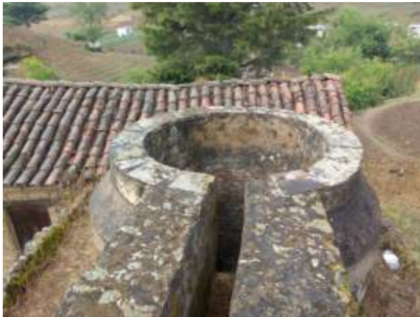
Vista del pozo o cubo del molino.
