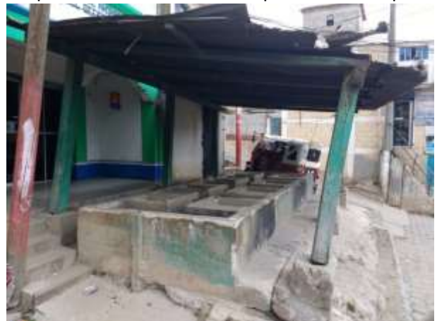
PCR Lavadero Municipal vista al este.
