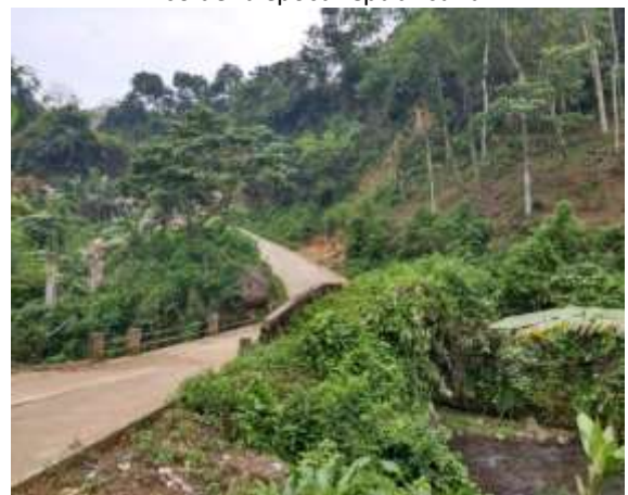
Vista panorámica sur del puente.
