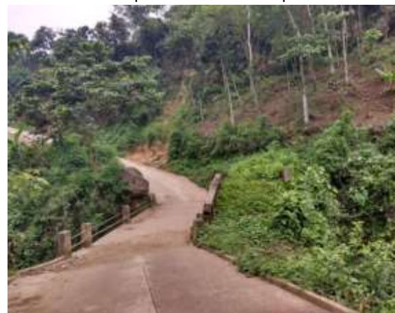
Vista parcial del camino que conduce a Xejuyub.
