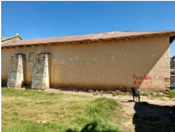
Vista lateral de terreno e Iglesia.
