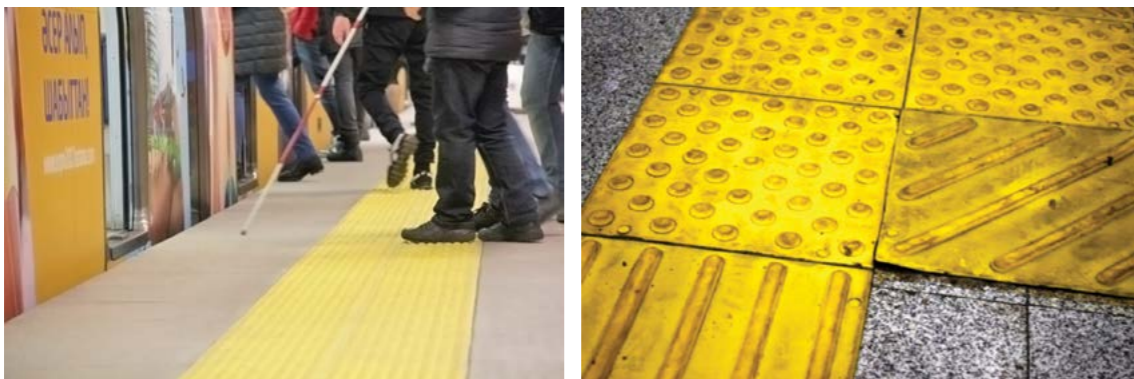
Тактильные указатели метрополитена г. Алматы
