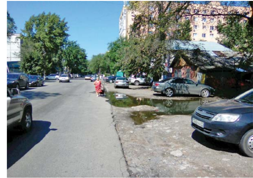
Отсутствие тротуаров на некоторых улицах
