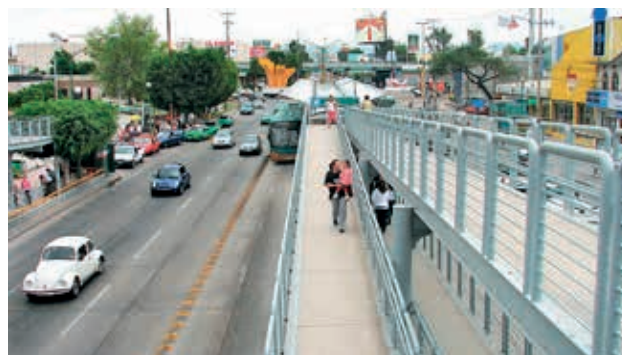
Рисунок 13 Пешеходная эстакада с пандусом и площадкой для отдыха в г. Леон, Мексика
