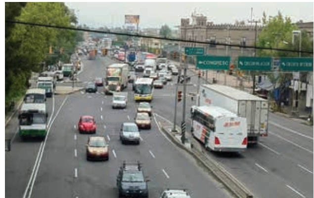
Рисунок 85 «Eje 3 Oriente Eduardo Molina» до изменений, на улице устроены полосы с направлением движения, встречным основному транспортному потоку, и по ходу движения требуется перестраиваться на другую сторону улицы.
