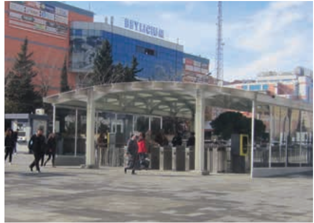
Рисунок 69 Слева: перегруженный вход на остановочный комплекс в вечерний час пик в районе «Cevizlibağ» в старой части коридора «Metrobüs»; справа: улучшенный вход на остановочный комплекс с турникетами на пешеходной площади выше уровня проезжей части коридора.
