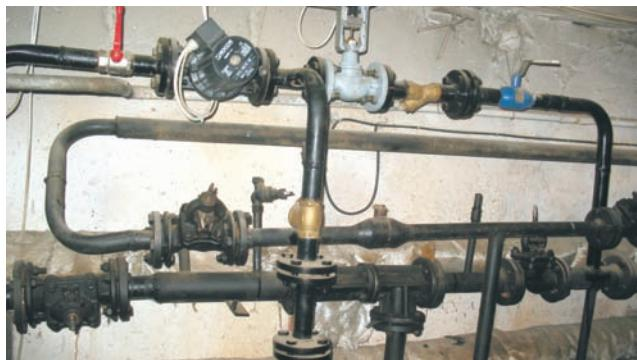
**Фото. Тепловой пункт в подвале дома обеспечивает нас теплом и горячей водой**
