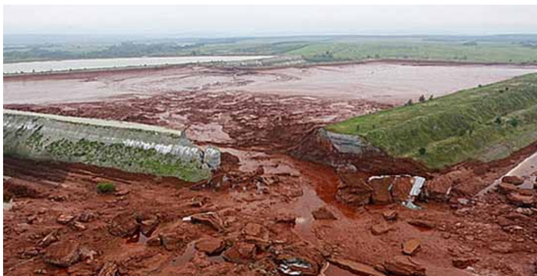
Fotografija 3. Kolaps jalovišne brane u Mađarskoj 2010. godine.
