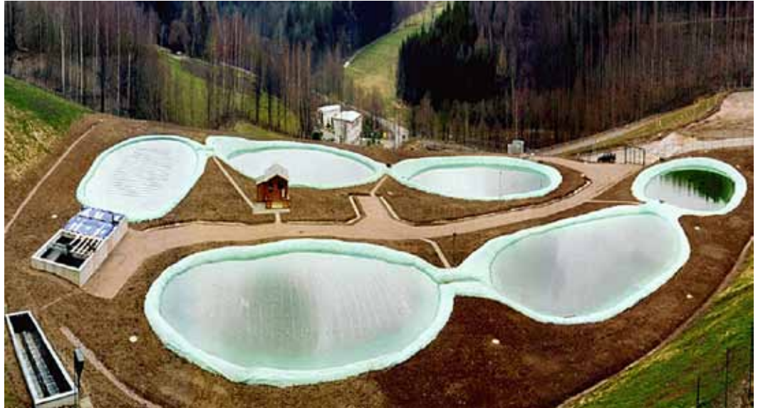
Fotografija 3. Kompletan tretman prerade kiselih otpadnih voda koje potiču iz rudnika u Nemačkoj, močvare Pöbla.
