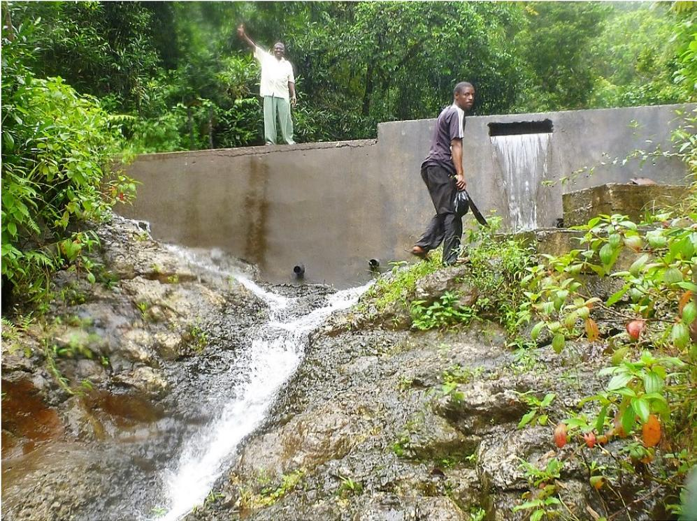
Figure 6 : Structure type des prises d'eau.
