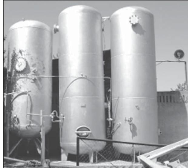
Газгольдерная установка для сбора и хранения биогаза в селе Петровка (фотография предоставлена ОсОО «Демонстрационная зона энерго- и водозэффективности»).
