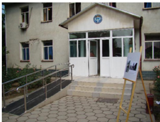
Вход в здание Кара-Сууйского районного суда после реконструкции лестничной площадки и установки пандуса с перилами.
