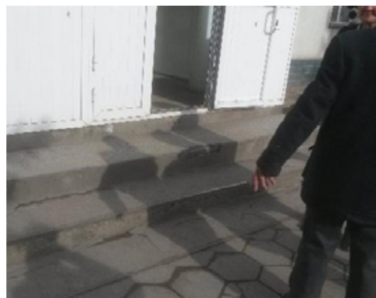
Вход в здание Кара-Сууйского районного суда до проектных мероприятий.
