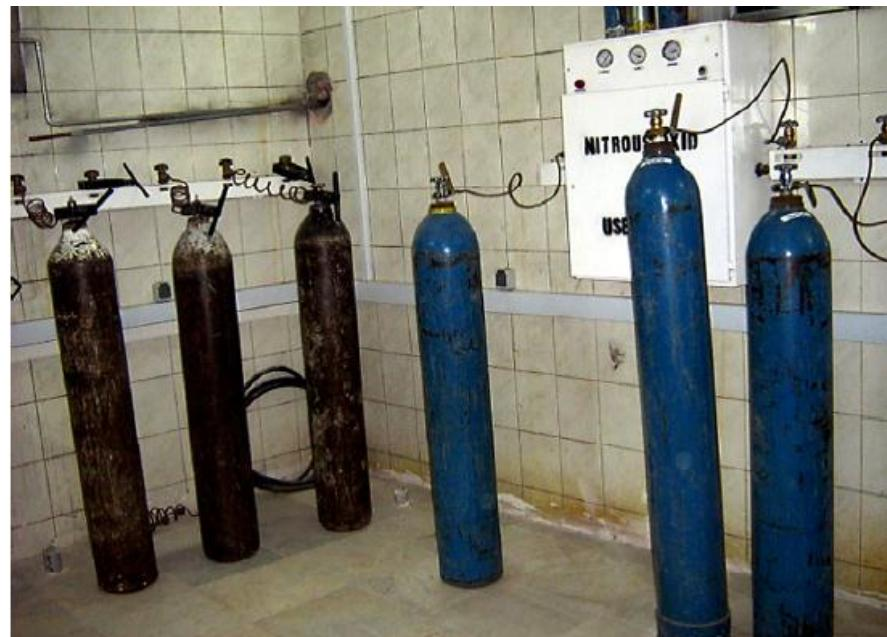
تصویر ۸- عدم مهار مناسب کپسول‌های اکسیژن به دیوار
