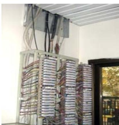
سیستم مخابرات تلفنخانه باید توسط نبشی فلزی و پیچ به بدنه و دیوار فیکس شود. این کار باید در دو سمت تابلو انجام گیرد.
