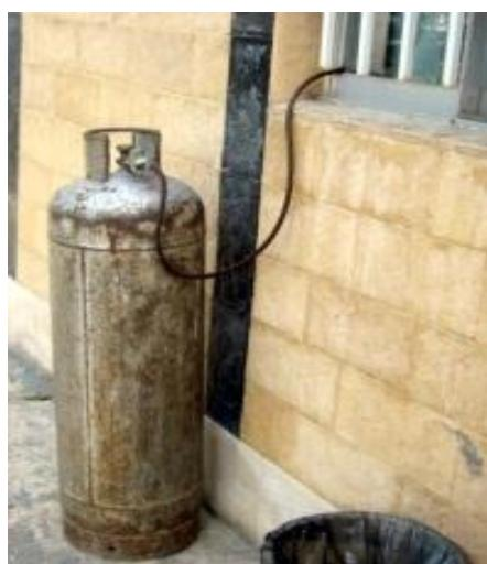
برای مهار کپسول ها از صفحه فلزی U شکل که به دیوار پیچ شده و مهار نایلونی استفاده شود.
