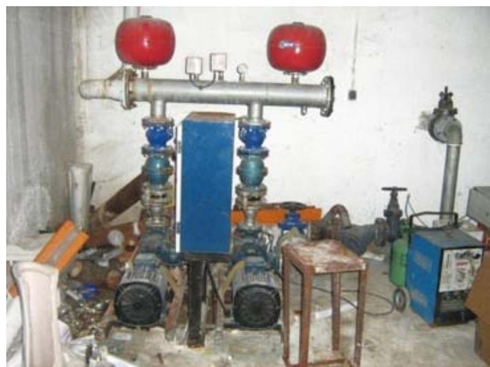
تصویر ۹۳- عدم استفاده از اتصالات انعطاف پذیر در تاسیسات مکانیکی
