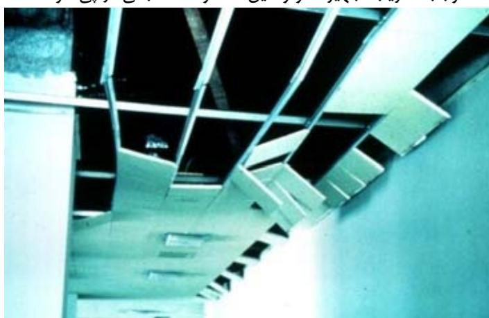
تصویر ۲۳- فروریختن سقف کاذب بر اثر عدم اجرای صحیح و اتصال نامناسب آن به سازه اصلی
