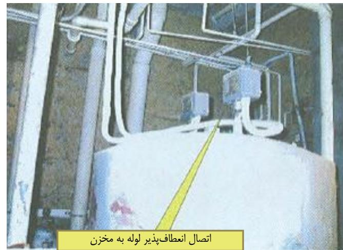
تصویر ۳۴- استفاده از اتصالات انعطاف‌پذیر در محل اتصال لوله به مخزن
