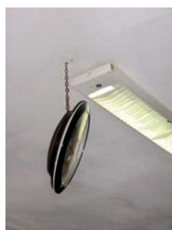
جهت اتصال ساعت به سقف باید از مهار فلزی نگهدارنده که به شبکه فلزی سقف متصل شده است، استفاده شود.
