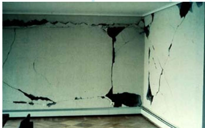
تصویر ۲۲- خرابی دیوار جداگر بر اثر عدم اتصال صحیح دیوارهای غیرسازه‌ای به اجزای سازه‌ای
