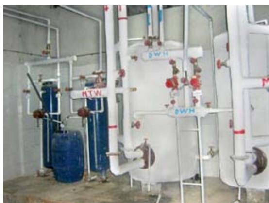
تصویر ۱۹- اتصال شکننده لوله‌ها در اتصال به مخزن اصلی
