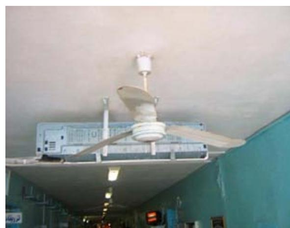
جهت اتصال پنکه سقفی به سقف باید از مهار فلزی که به شبکه‌های فلزی سقف متصل می‌شود، استفاده شود.
