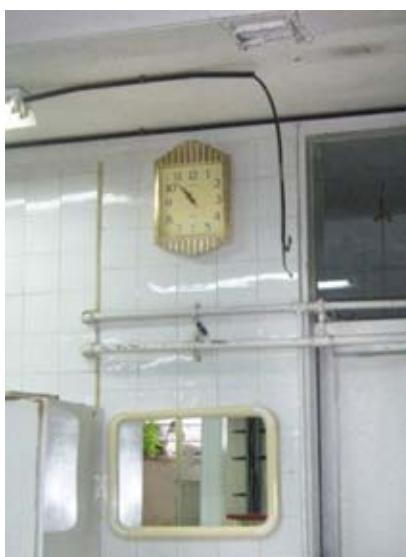
در این روش، باید آینه به مهار فلزی که دارای قلاب ۴۵ درجه بوده و به دیوار پیچ شده است، متصل شود.
