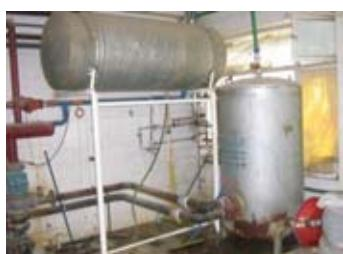
جهت تثبیت پایه این نوع تجهیزات باید از مهارهای فلزی که از یک سر به بدنه و از سر دیگر به پایه متصل هستند، استفاده شود. همچنین باید پایه های مخزن تا عمق ۲۰ سانتی متر در سکوی بنن مسلح قرار گرفته و توسط صفحه فلزی و پیچ به کف سکو متصل شوند.
