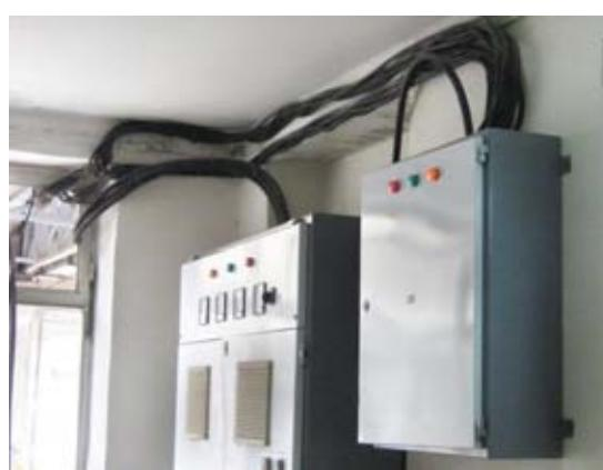
تابلو برق باید توسط نیشی فلزی و پیچ به بدنه و دیوار مهار شود. این کار باید در دو سمت تابلو انجام گیرد.
