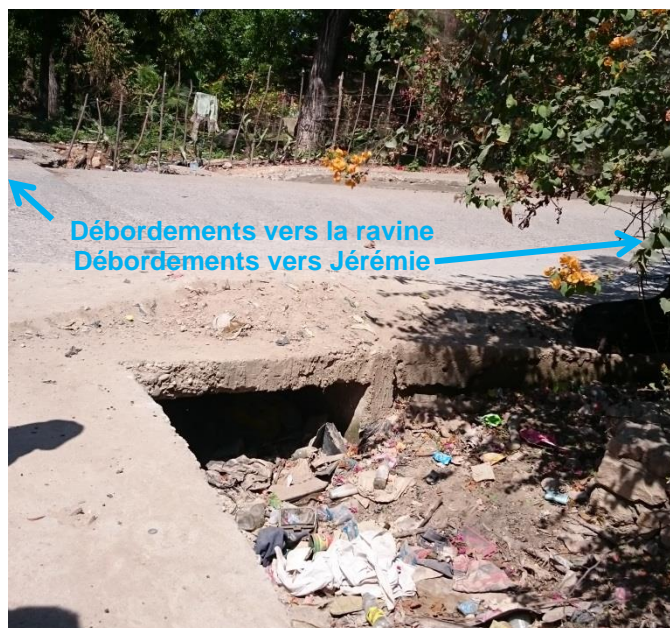
Fig. 23. Ouvrage de la route des Abricots, vue de l'amont
