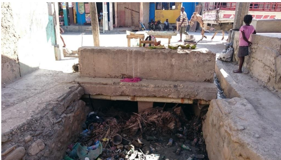
Fig. 19. Ouvrage hydraulique de la ravine Berquet
