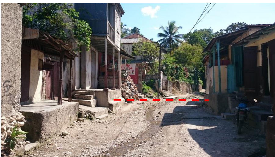
Fig. 17. Ravine Madame Kodo dans sa partie basse, avant la couverture (en rouge les niveaux régulièrement atteints)
