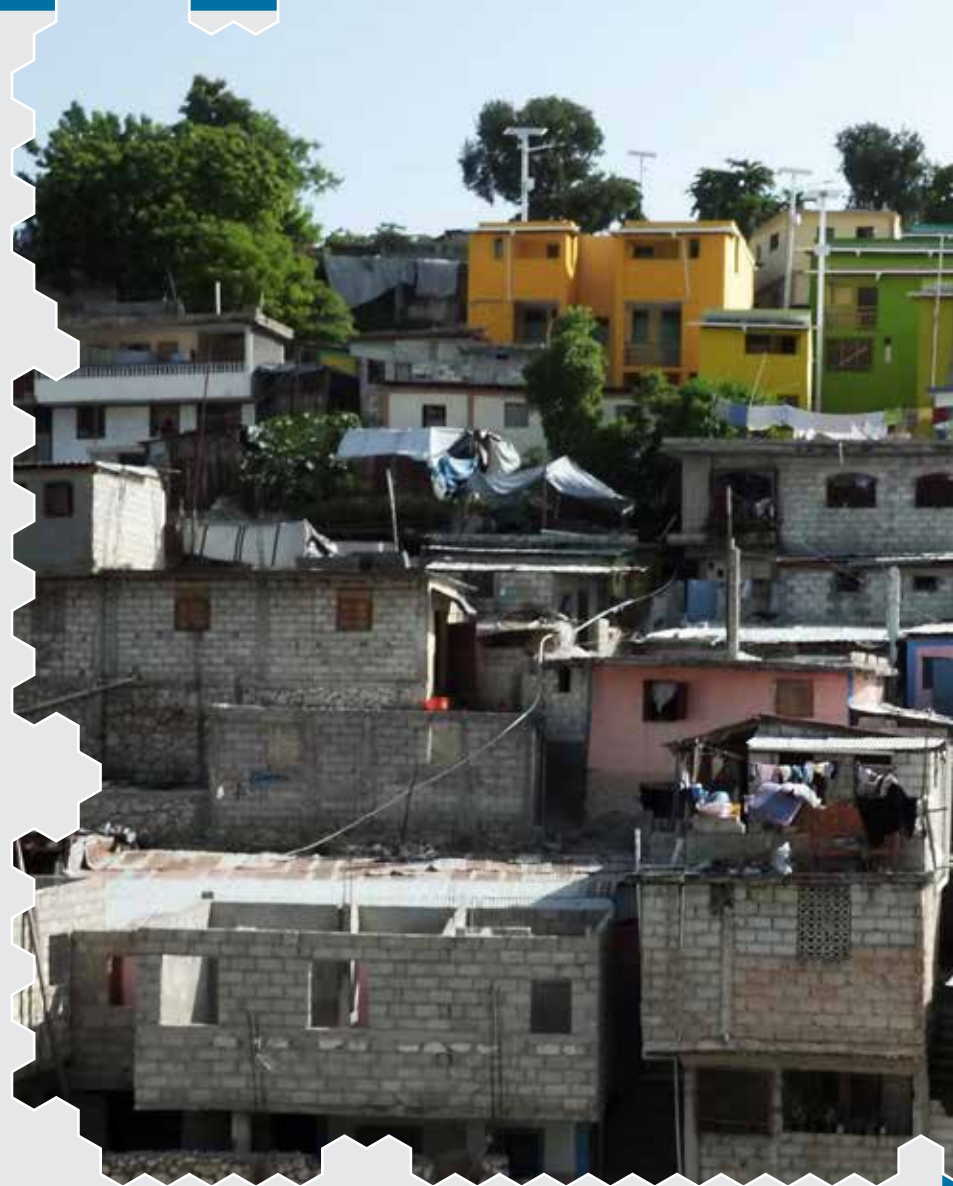
Photo : La collaboration entre le Gouvernement haïtien et les Nations Unies à travers le projet 16/6 vise, entre autre, à une réhabilitation des quartiers de sorte qu'ils puissent supporter d'autres secousses et ainsi faciliter le retour des personnes déplacées après le 12 janvier 2010.
