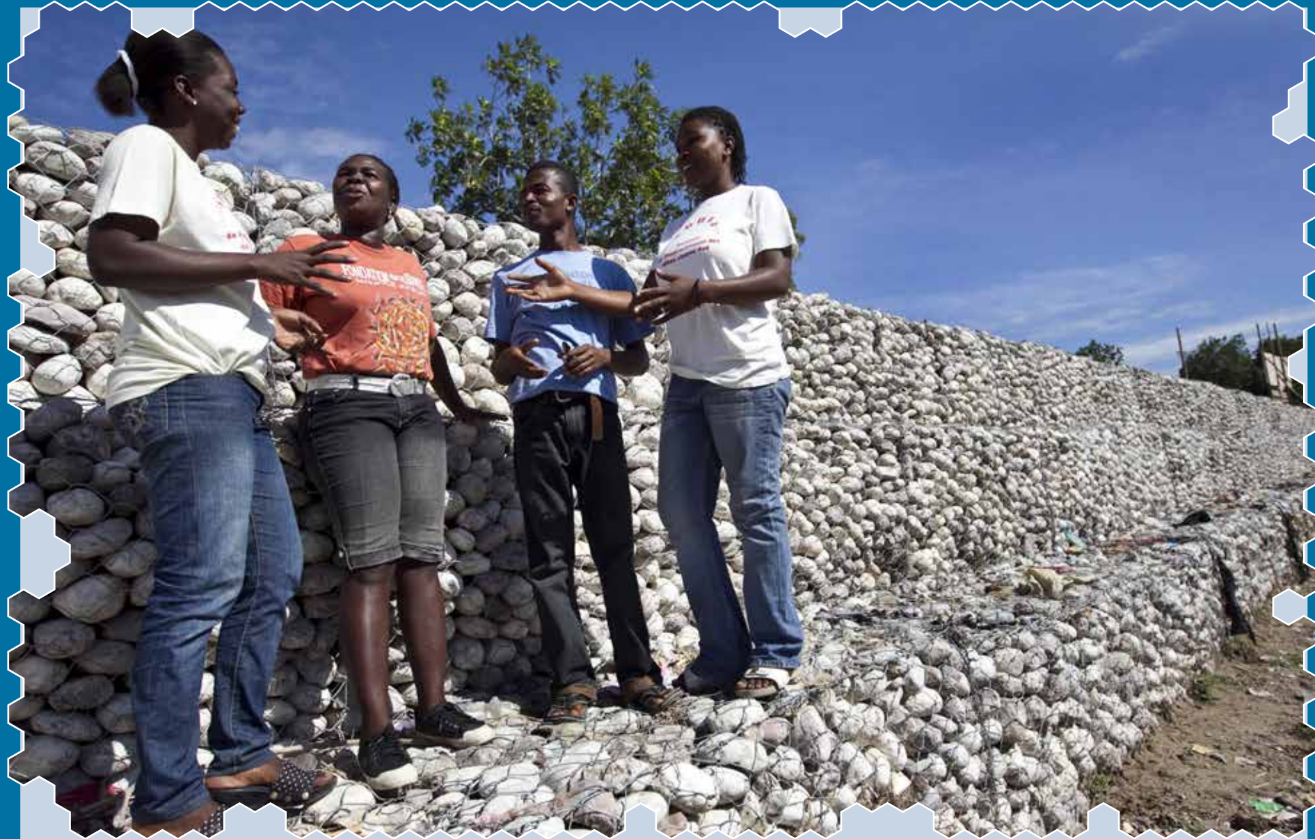
Photo : Les travaux de gabionnage permettent d'éviter les débordements des rivières et les inondations en cas d'intempéries et de crues.
