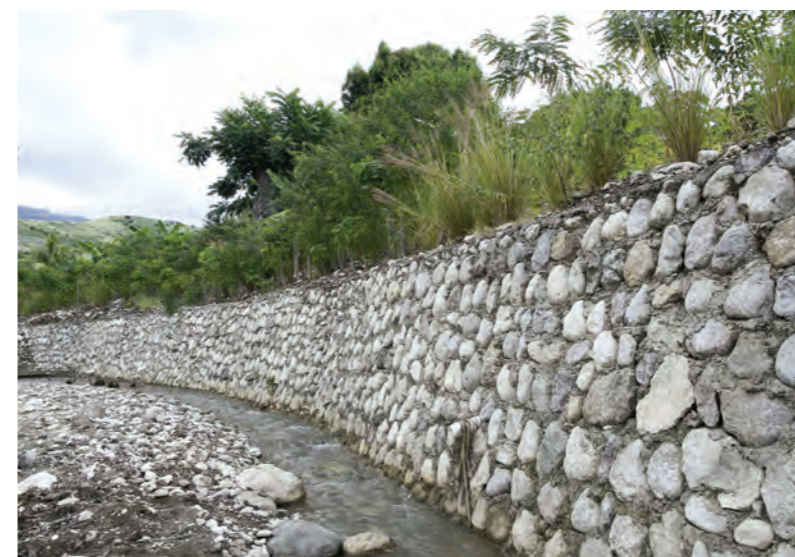
Une digue de protection est une mesure structurale permettant de protéger certains enjeux
